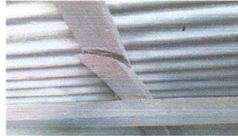
Foto 4: sustitucion de estructura de soporte de madera por metal en Cocina Escolar
