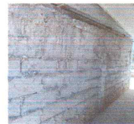
Foto 6: Repello de paredes interiores y exteriores en Cocina Escolar
