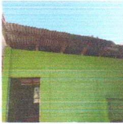
Foto 1: Sustitución de lamina por lamina troquelada aluzinc calibre 26 en Cocina Escolar
